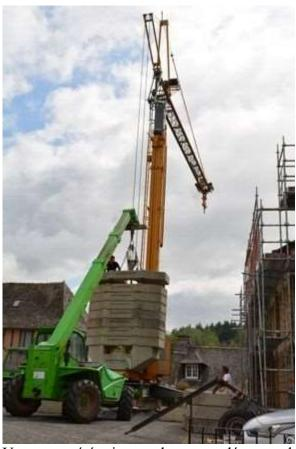
Une grue a été mise en place pour démonter le pignon et la charpente. © Droits réservés
